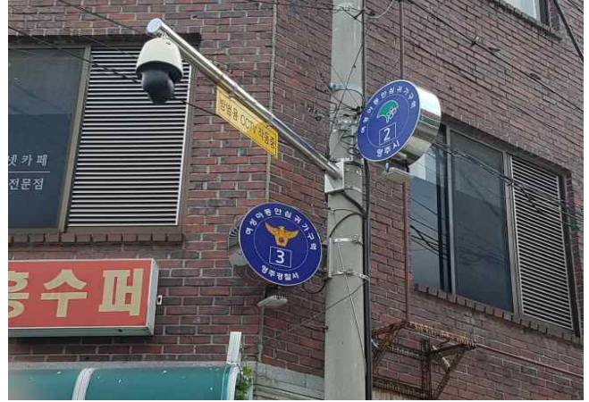
CCTV, 안전 보안등
