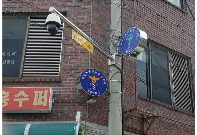
CCTV, 안전 보안등
